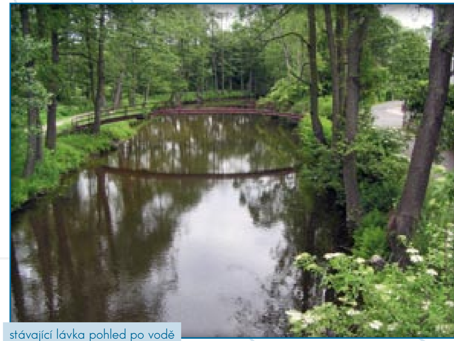
stávající lávka pohled po vodě
