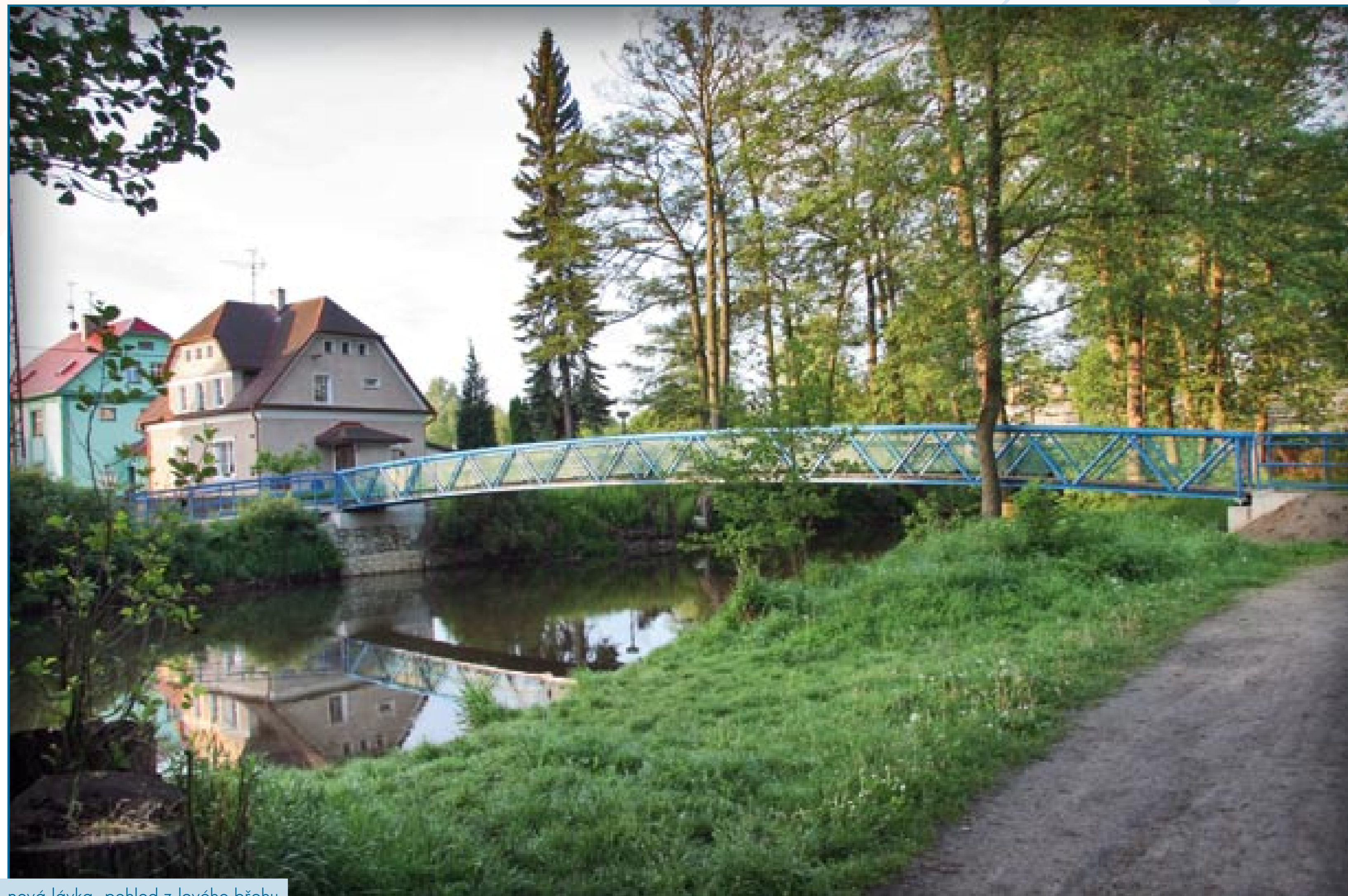
nová lávka - pohled z levého břehu
